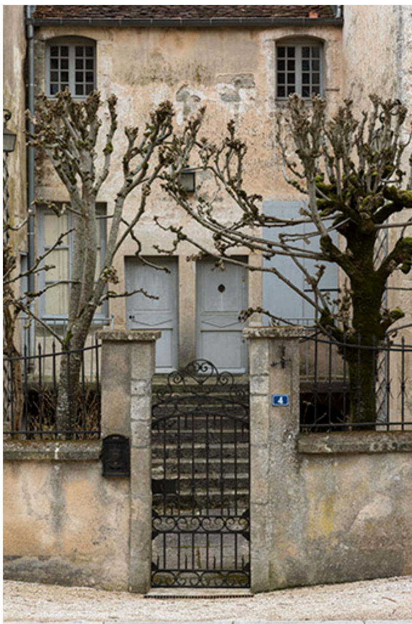
Façade antérieure : travées centrales.
