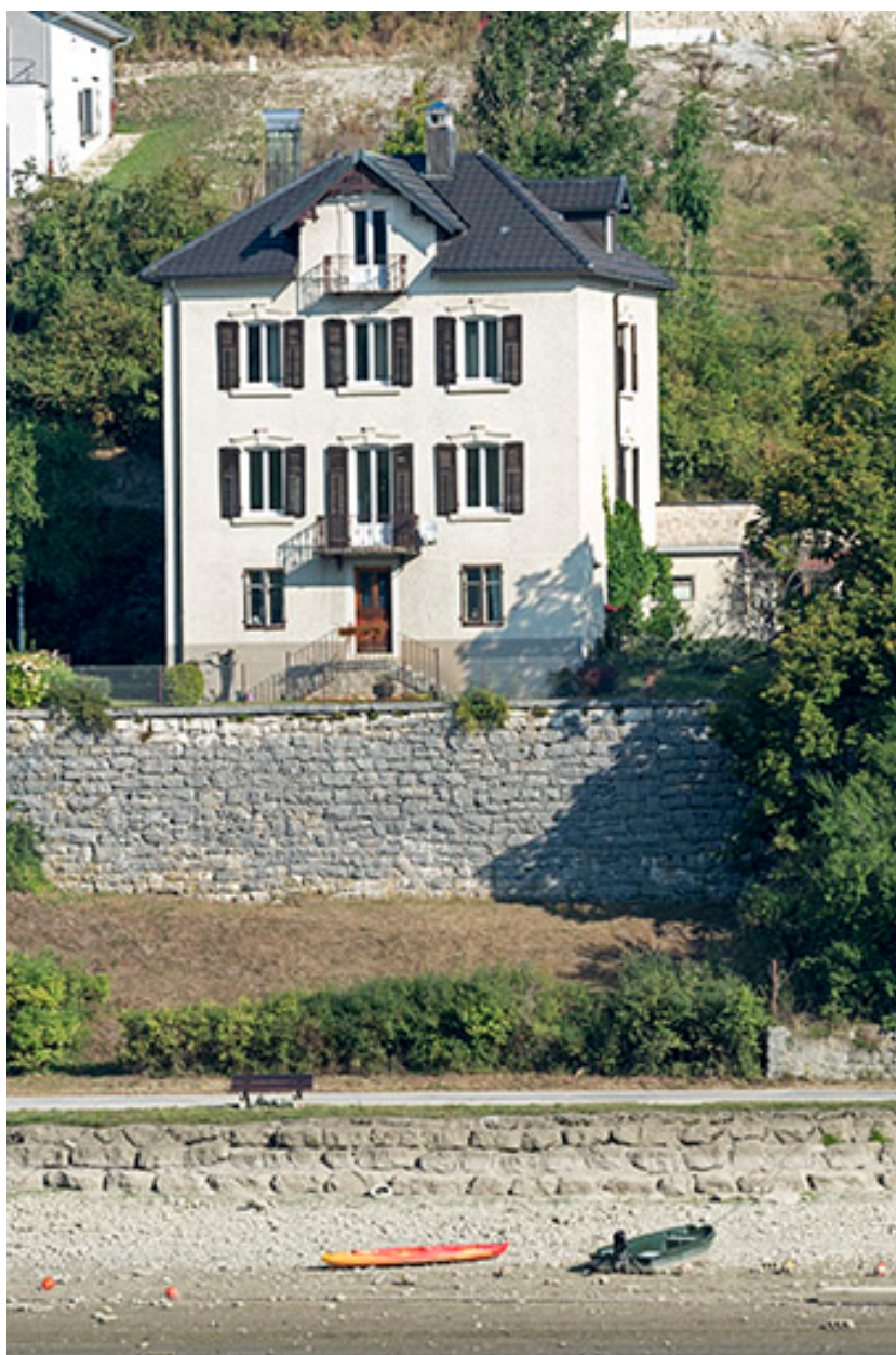
Vue d'ensemble, depuis le sud-est (façade postérieure).
