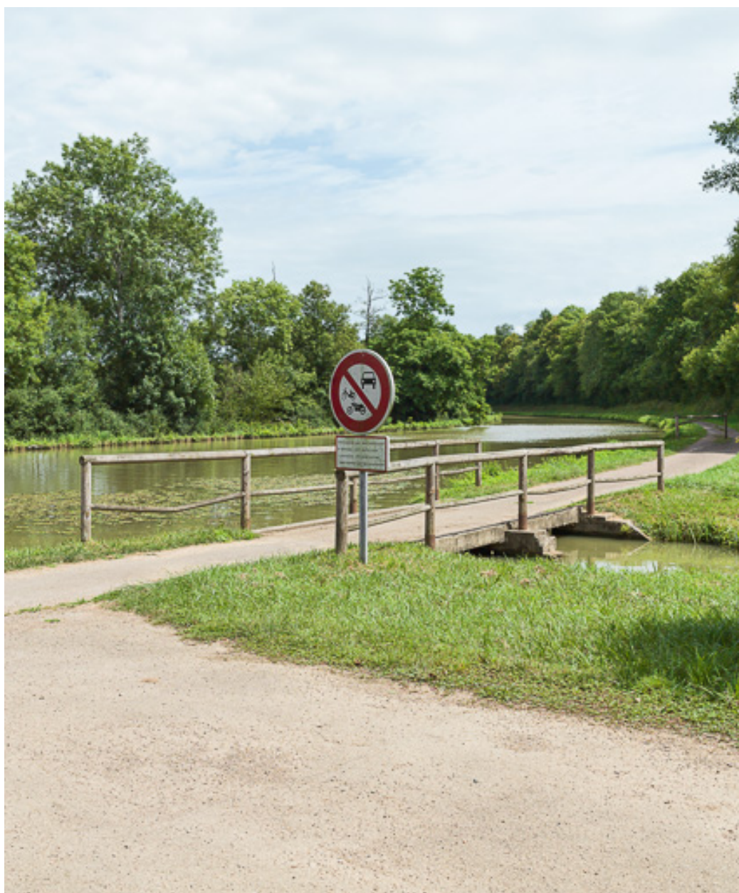
Vue d'ensemble de l'ouvrage.
