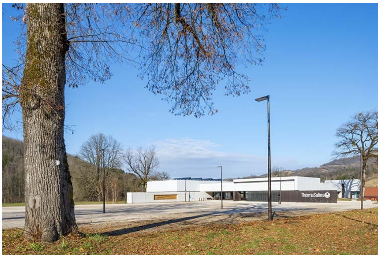
Parc de stationnement au sud de l'établissement.
