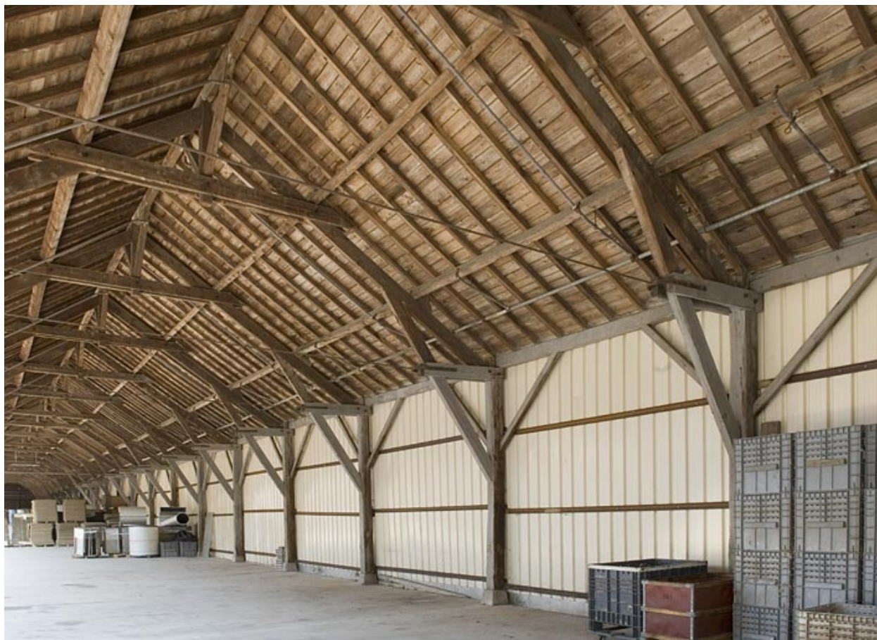
Fermes de la charpente de l'entrepôt industriel.
