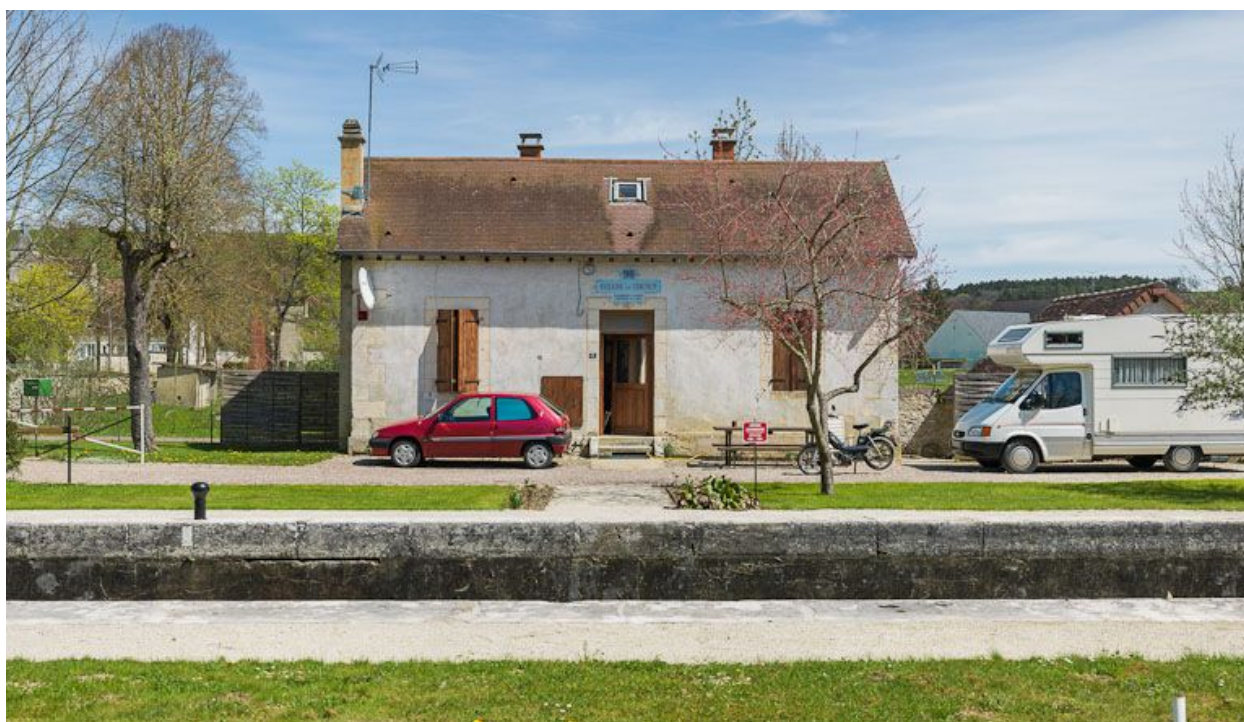
La maison éclusière de face.
