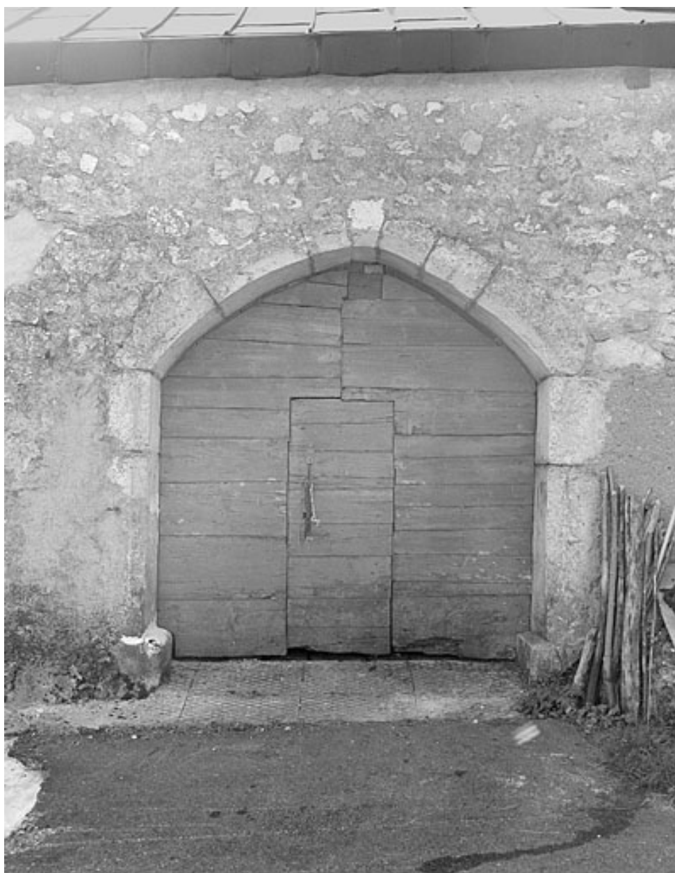
Porte de grange haute.
