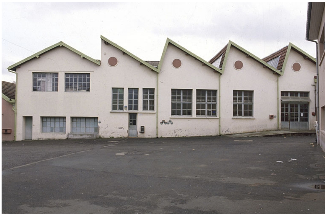
Pignons nord de l'ancien atelier de fabrication.
