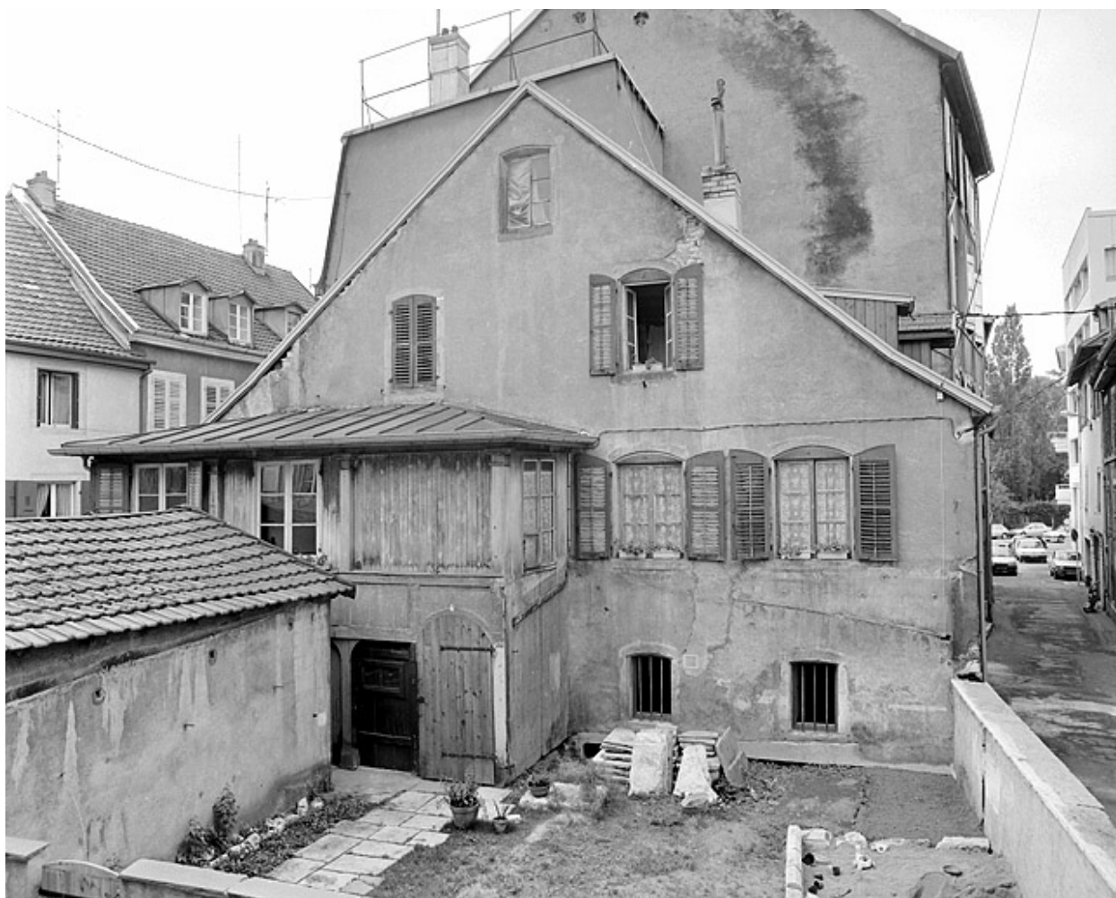
Façade sur cour.
