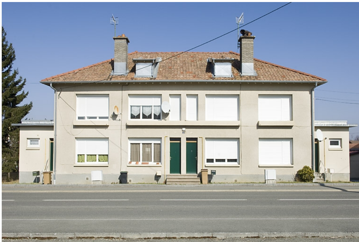
Habitation. Façade antérieure.
