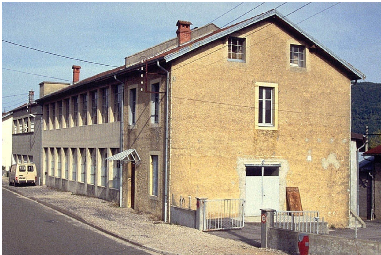
Usine de tabletterie (tournerie) de la coopérative la Tournerie ouvrière, Lavans-lès-Saint-Claude (8 rue de la Cueilie).
