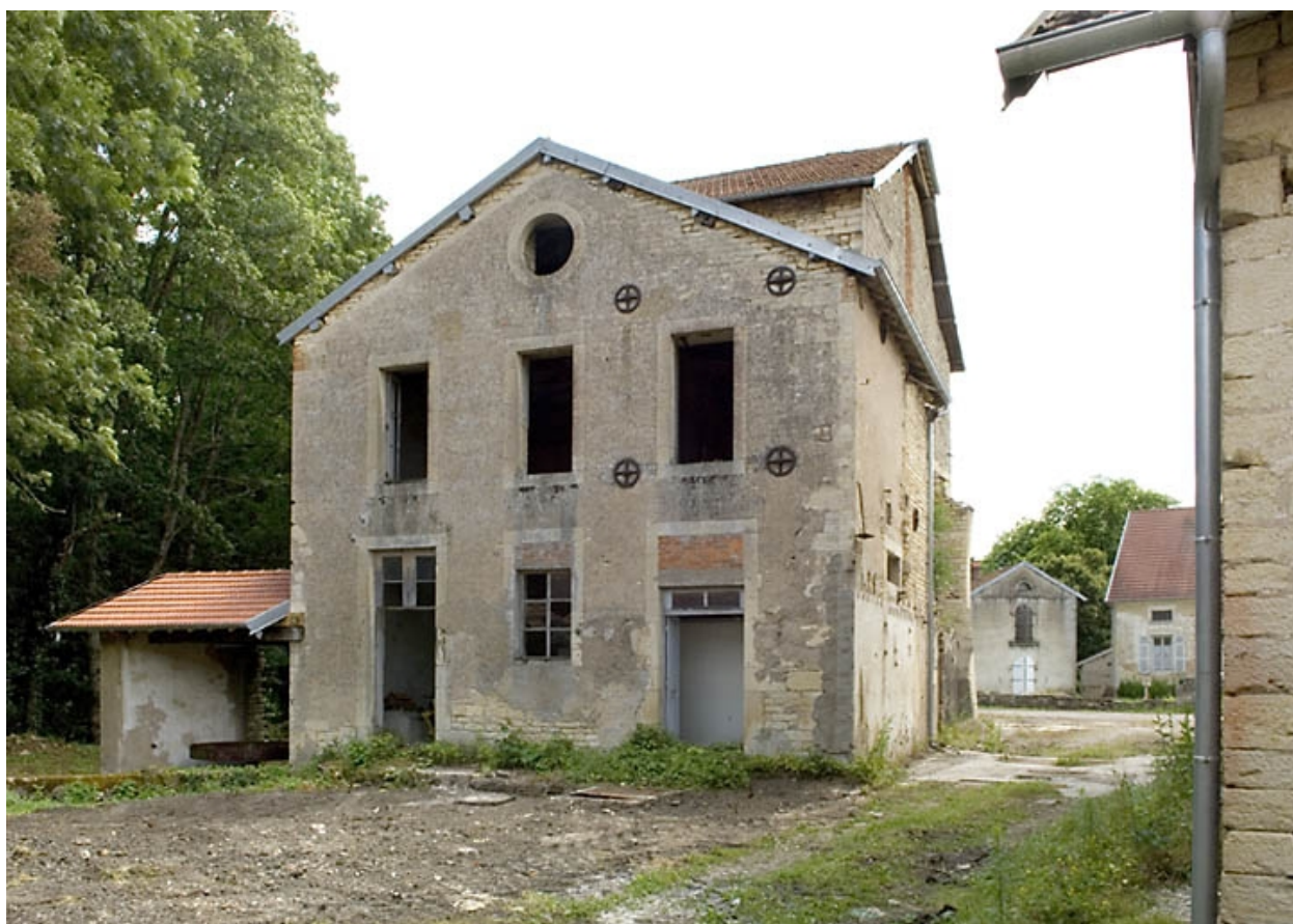
Façade ouest du haut fourneau.
