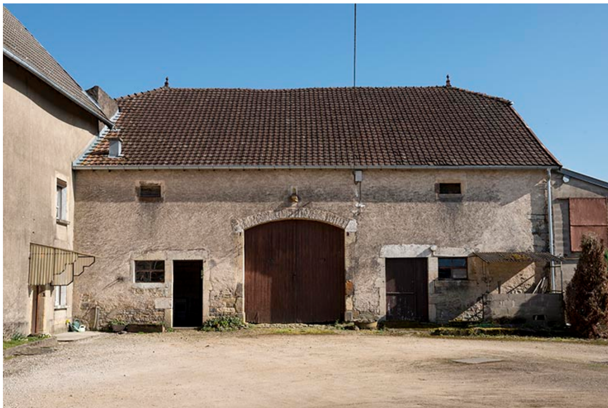
La grange attenante à la ferme.
