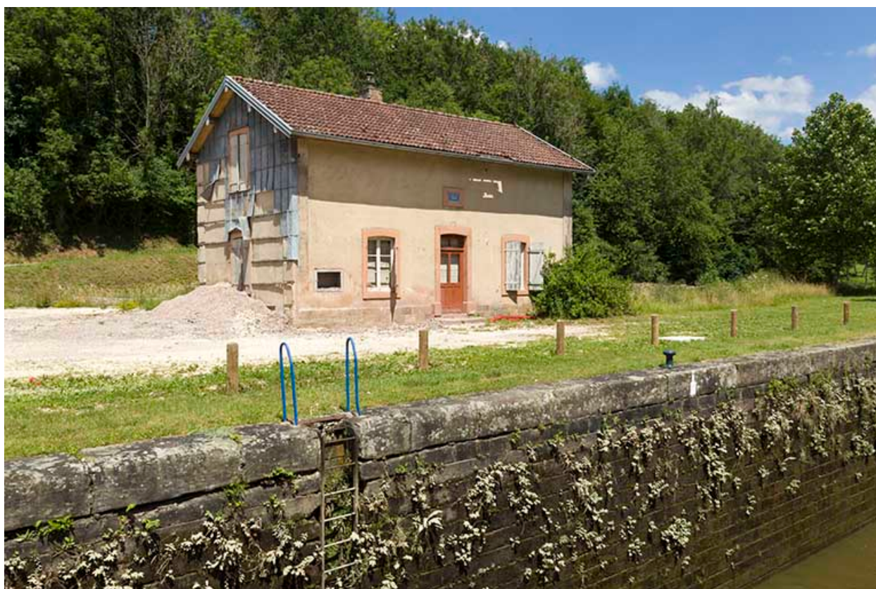
La maison d'éclusier, depuis l'écluse.
