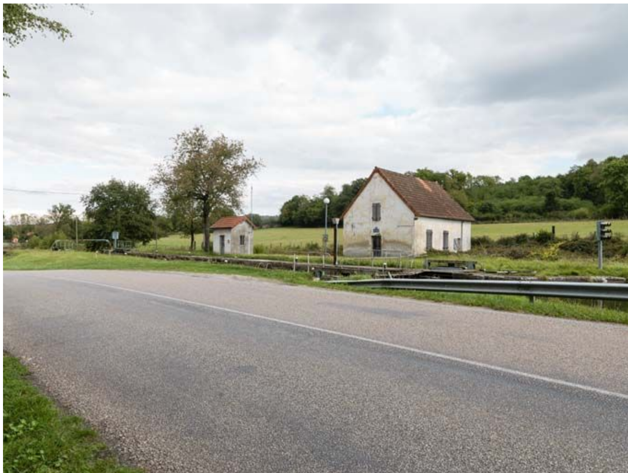
Vue d'ensemble du site d'écluse.
