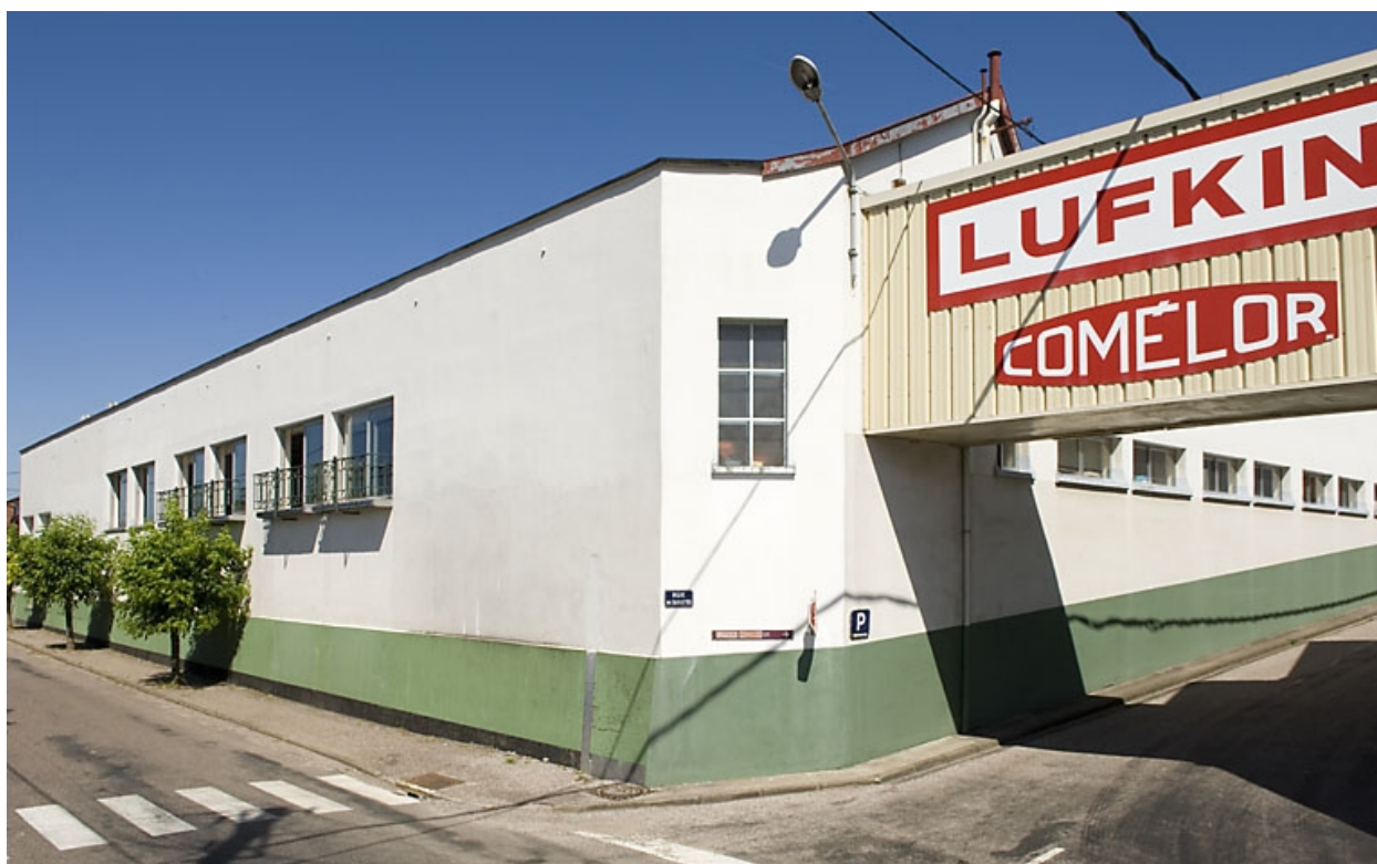
Façades des ateliers ouest.
