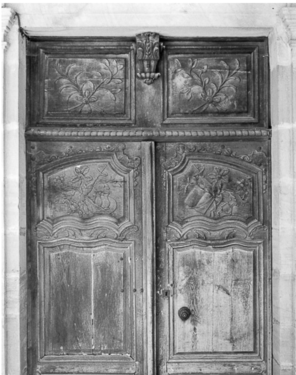
Vue d'ensemble de la deuxième porte d'entrée.
