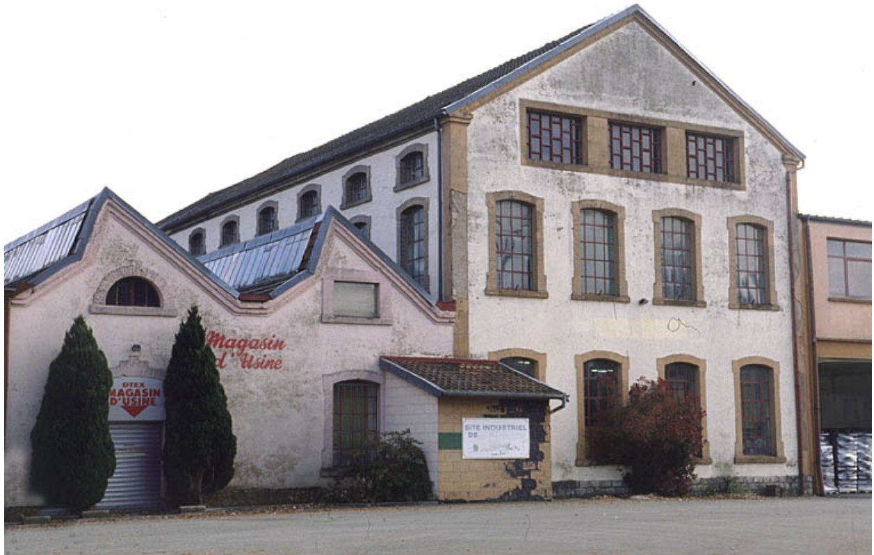
Pignons des façades antérieures.
