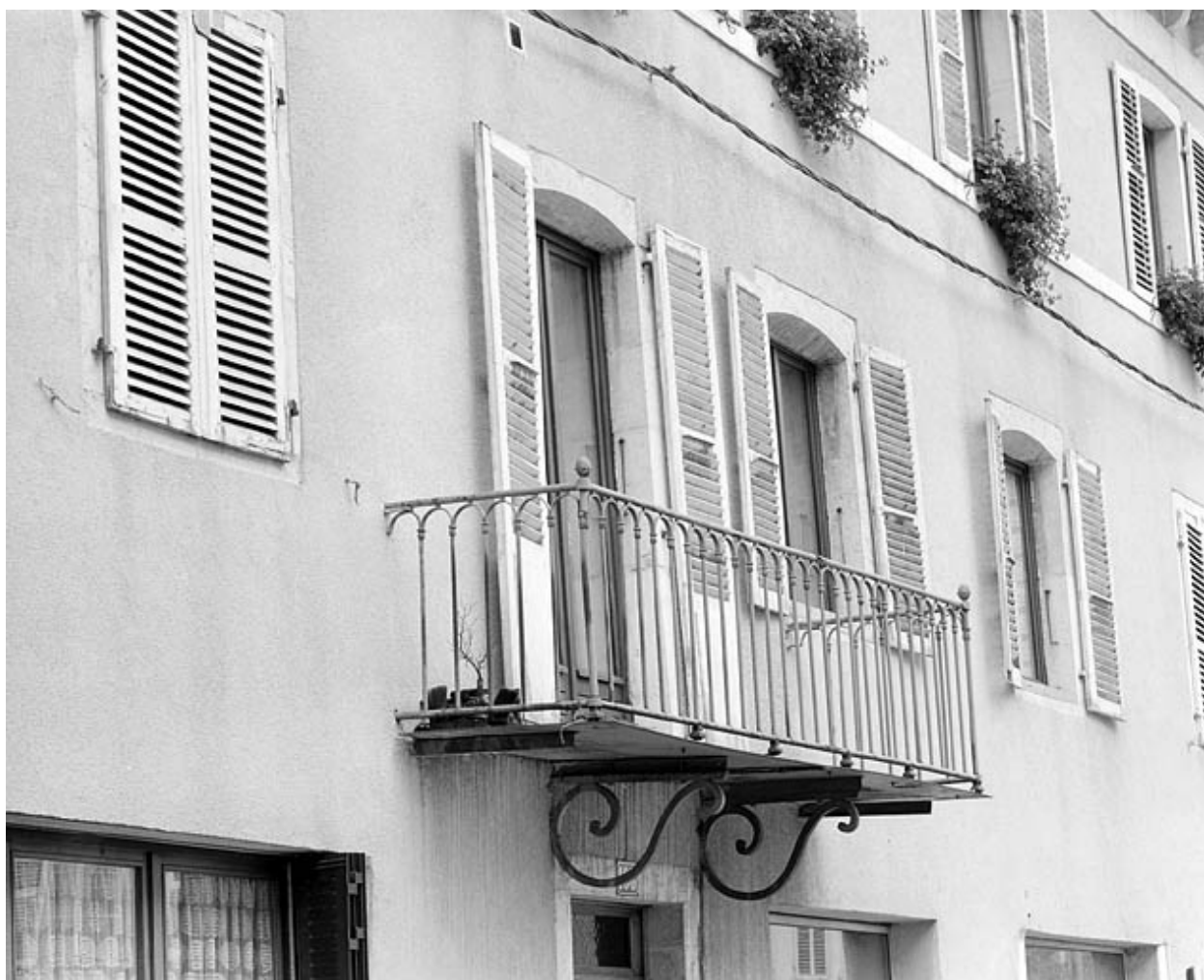
Balcon de la porte-fenêtre centrale.
