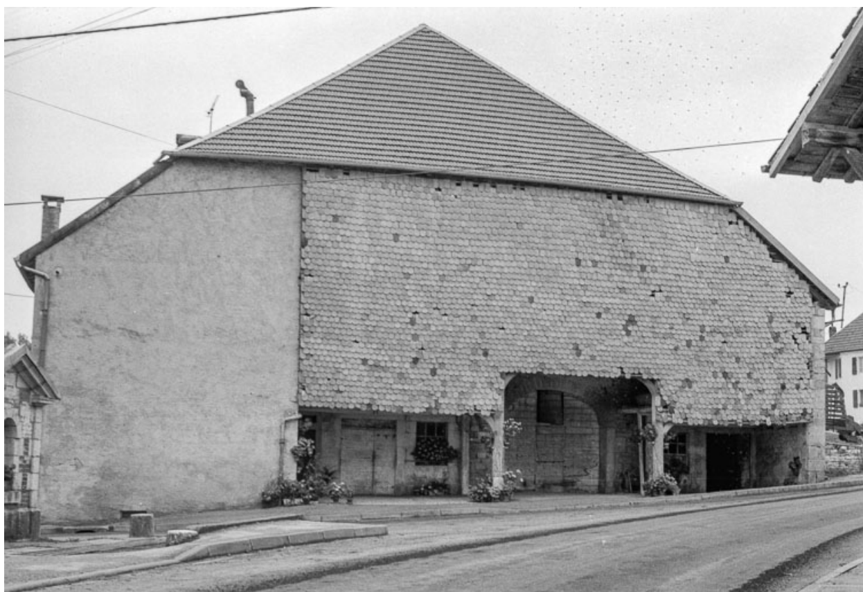
Façade latérale droite sur rue.
