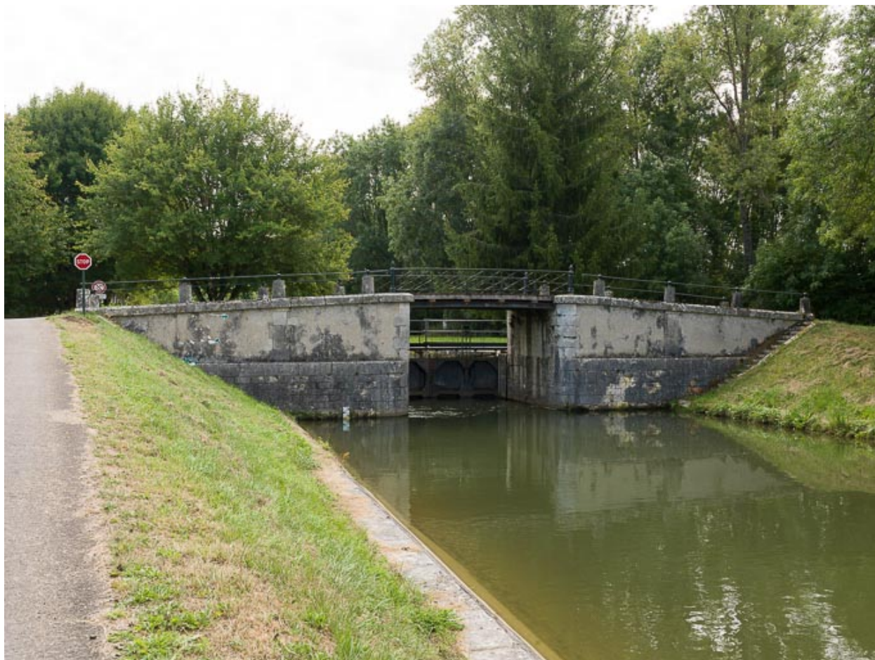
Vue d'ensemble du pont.
