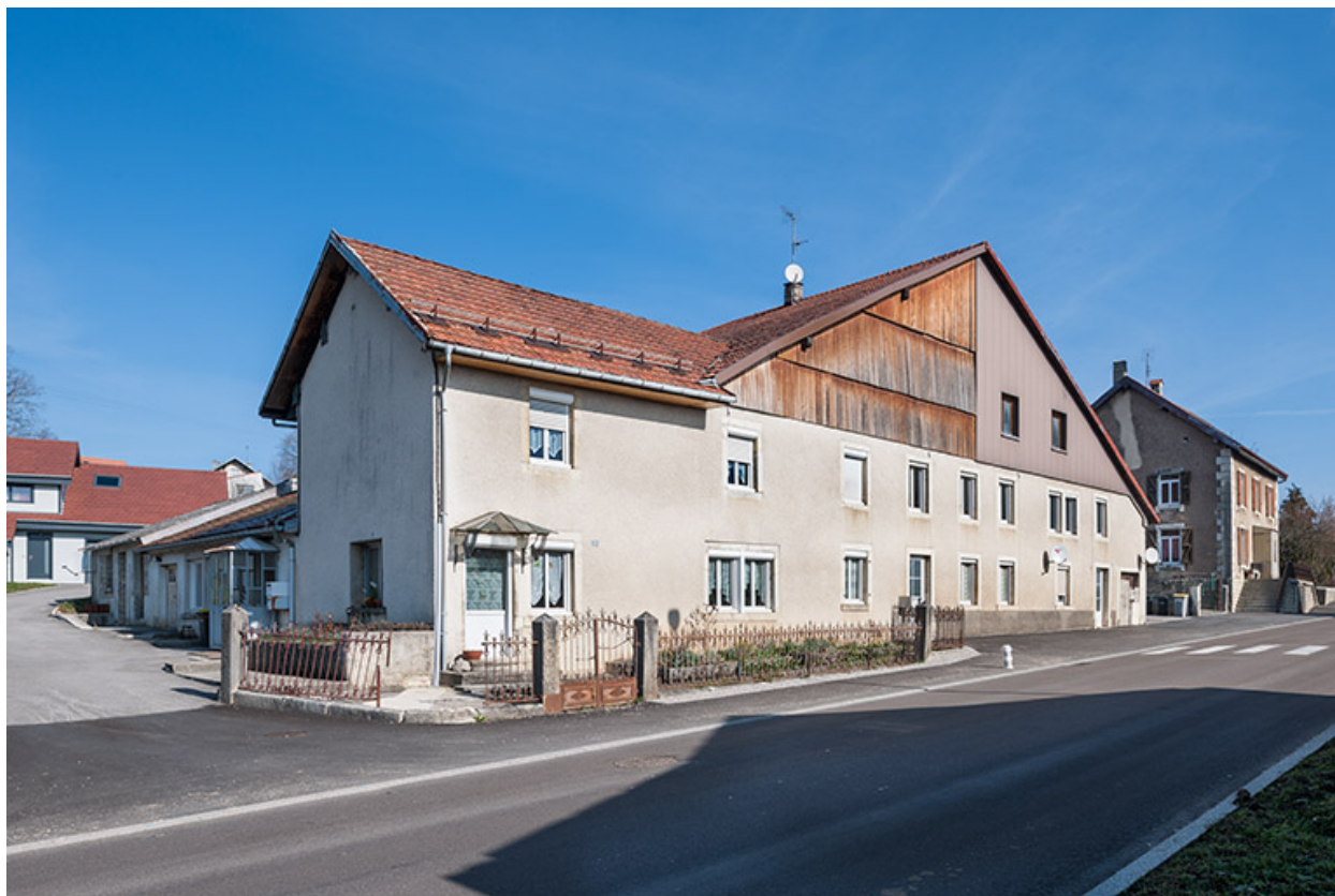
Ferme : façade antérieure, de trois quarts gauche.
