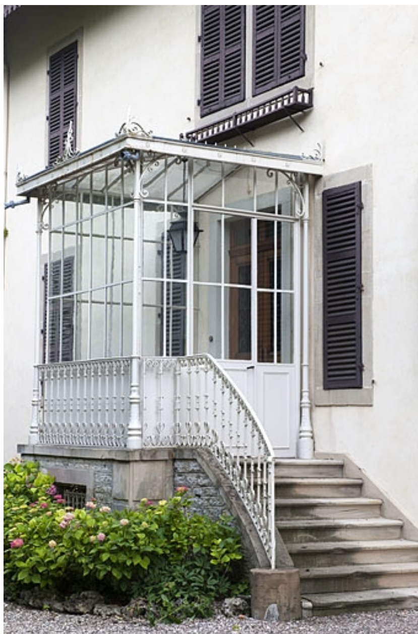
Escalier sur la façade est.
