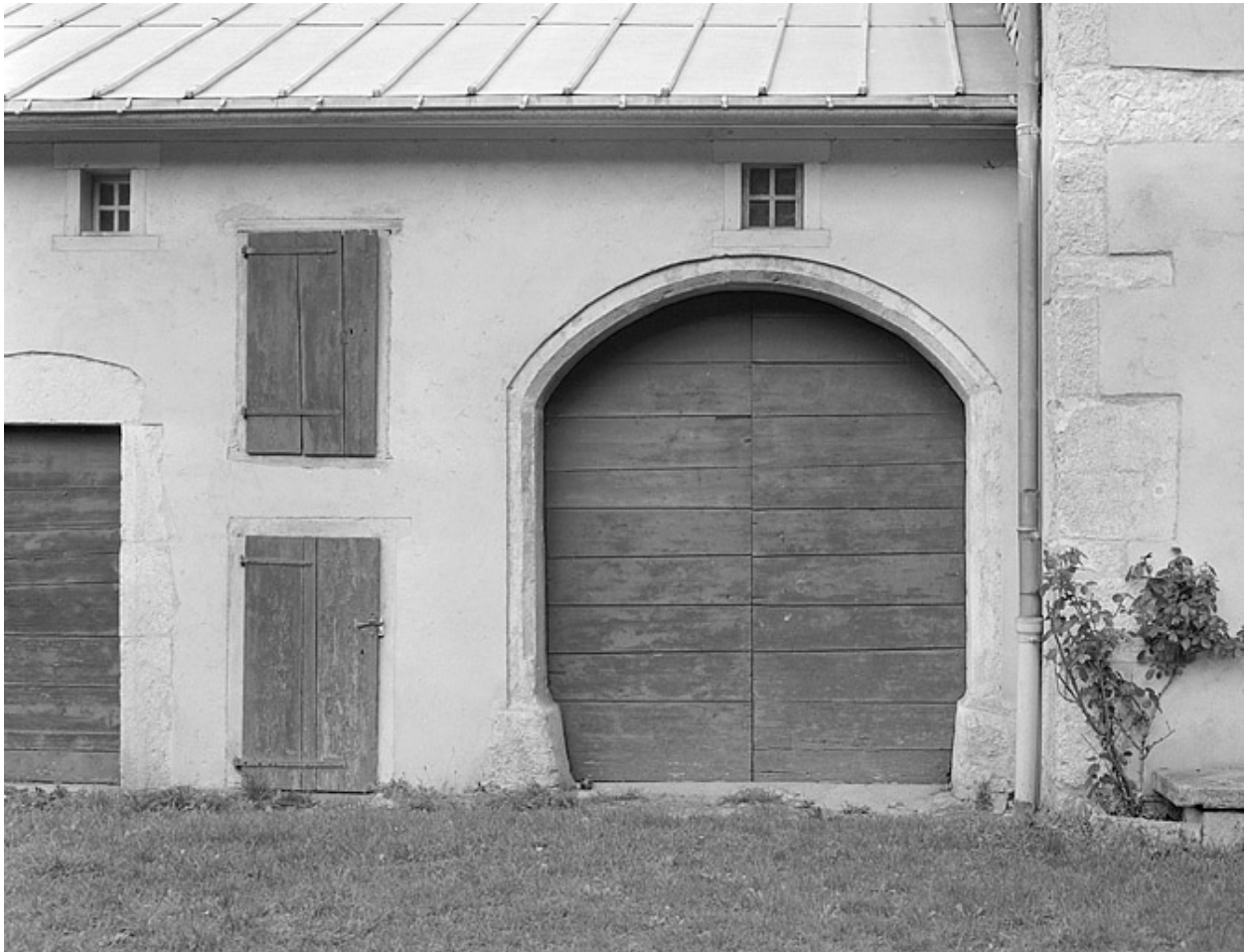
Porte d'accès aux communs.
