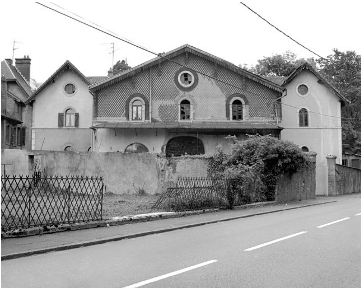
Façade postérieure de la ferme.
