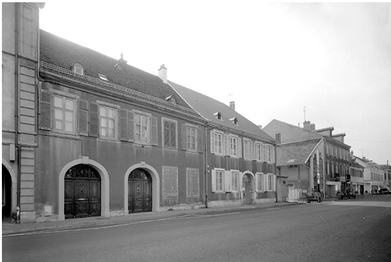
Vue d'ensemble avec la maison n° 63.
