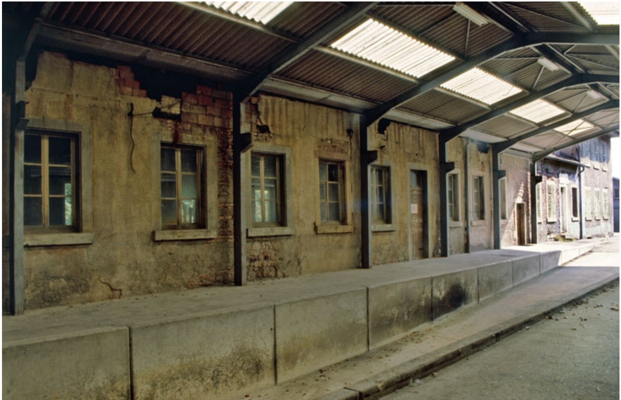
Quai couvert établi contre l'ancien tissage.
