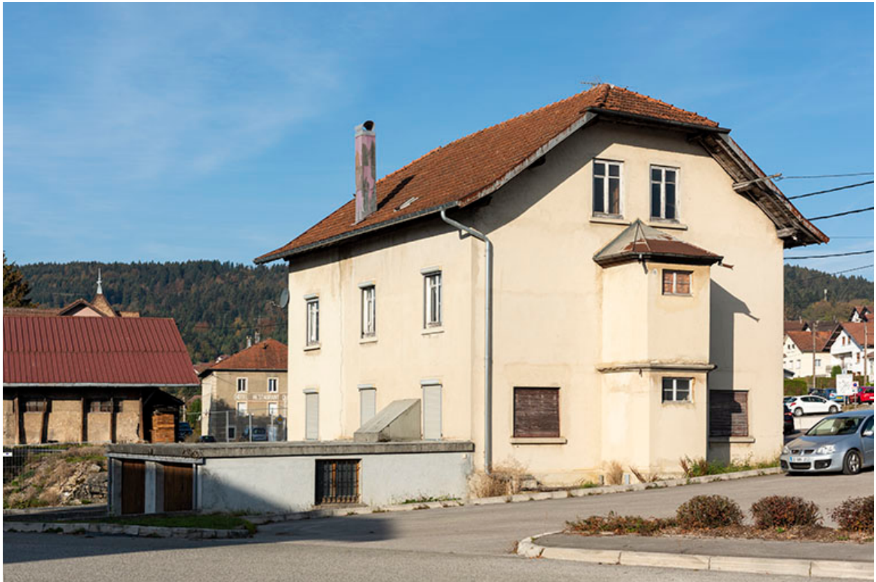
Maison de 1919 : façades postérieure et latérale gauche.
