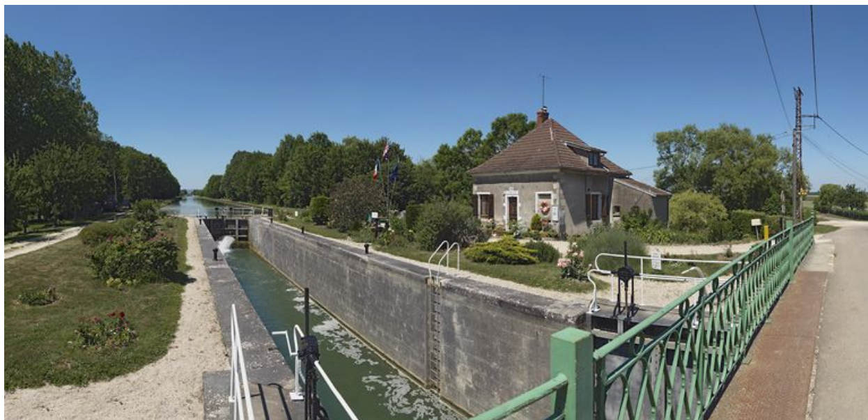
Le site vu d'aval.
