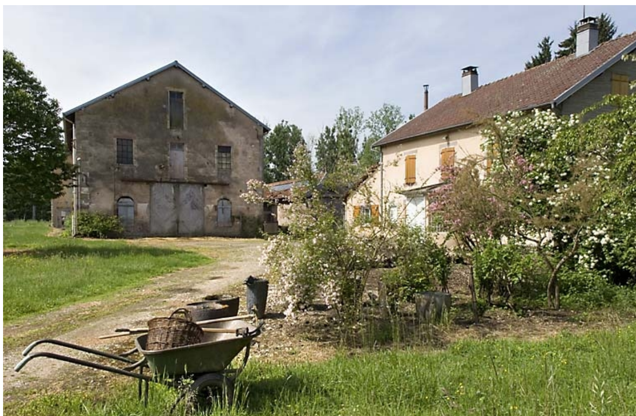
Atelier de filature et logement depuis l'est.
