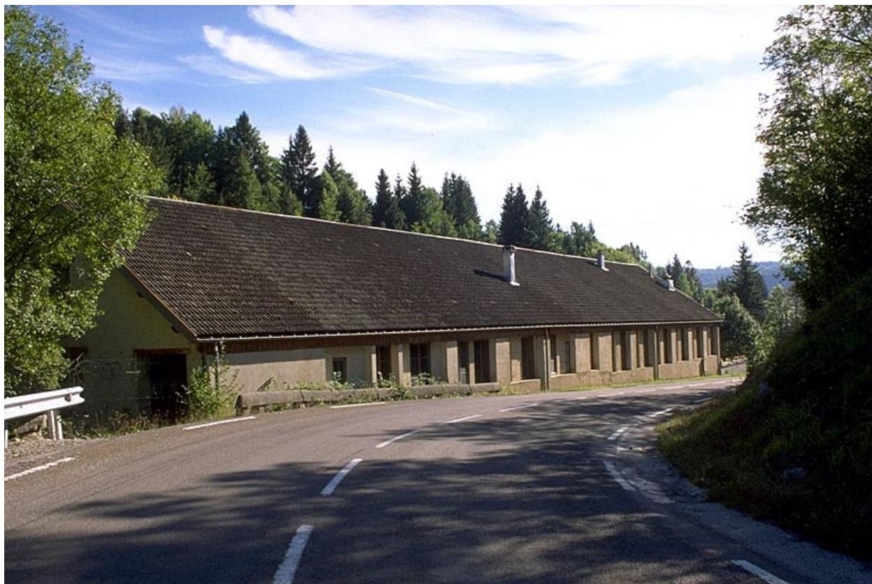
Usine de mécanique de précision puis de lunetterie Cottet puis de la Société des Lunetiers, Foncine-le-Bas.
