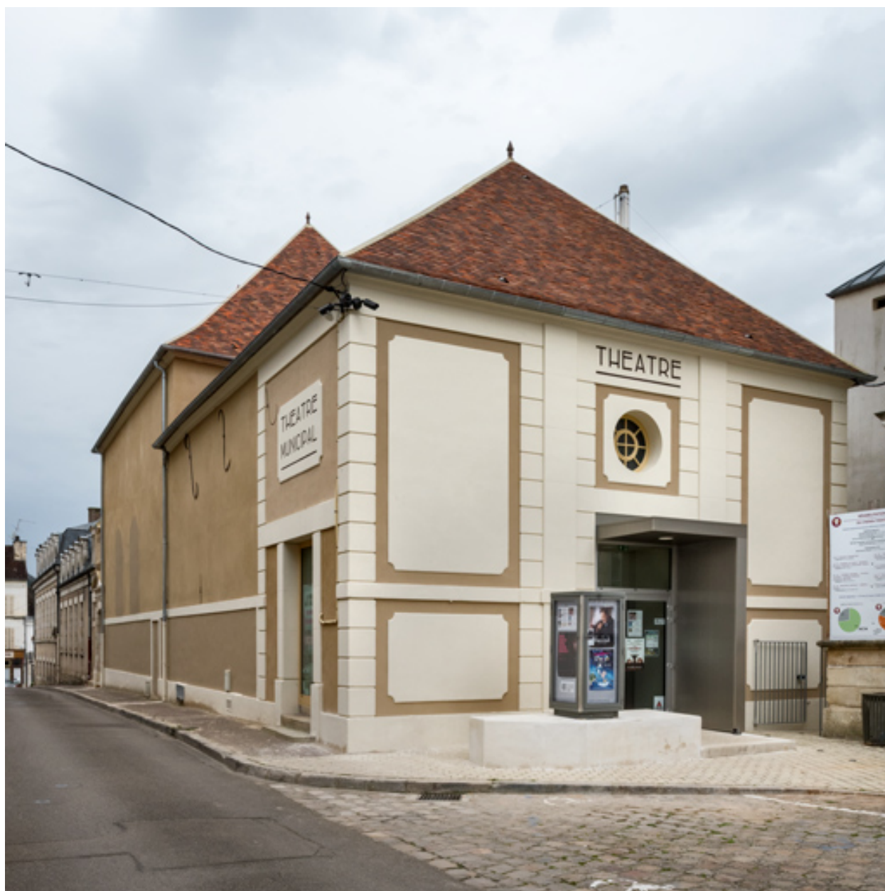
Façades antérieure et latérale gauche.
