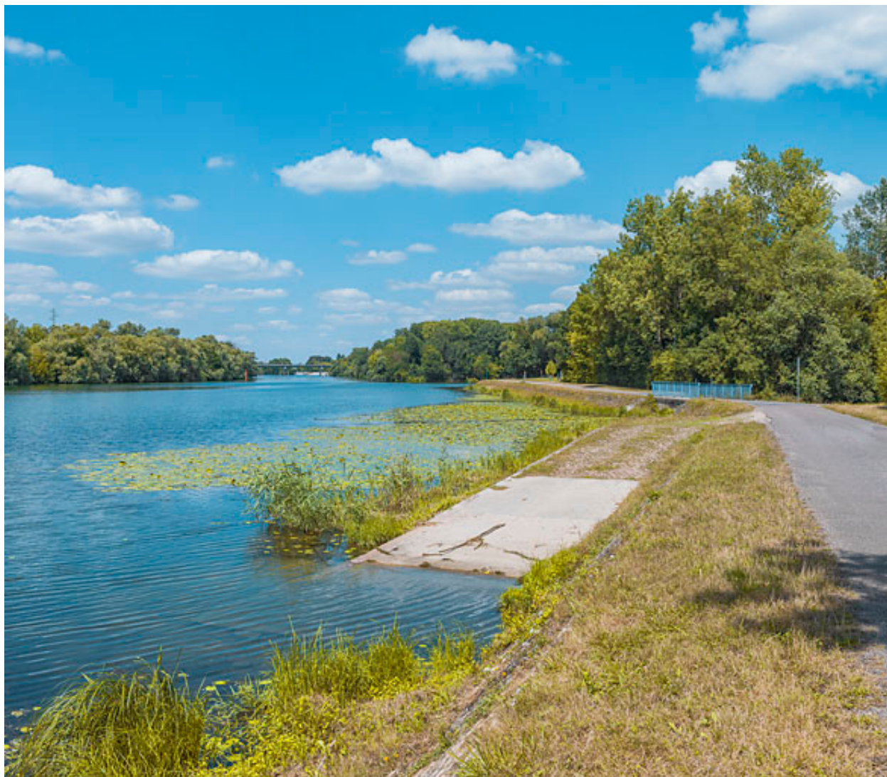
La rampe d'abreuvoir et les perrés.
