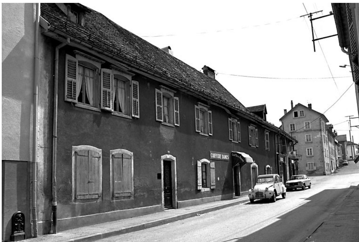
Façade sur rue de trois quarts gauche.
