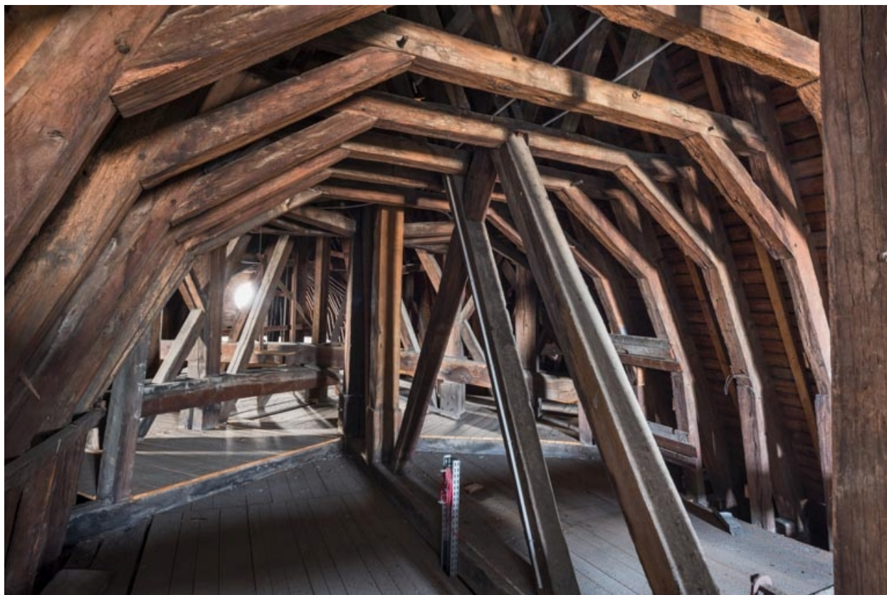
Comble : vue prise depuis le chevet oriental.
