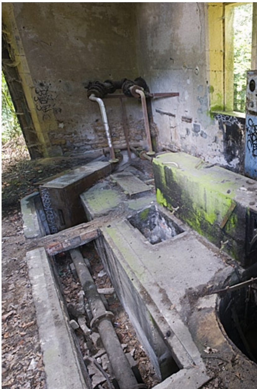
Station de pompage : détail de l'intérieur.
