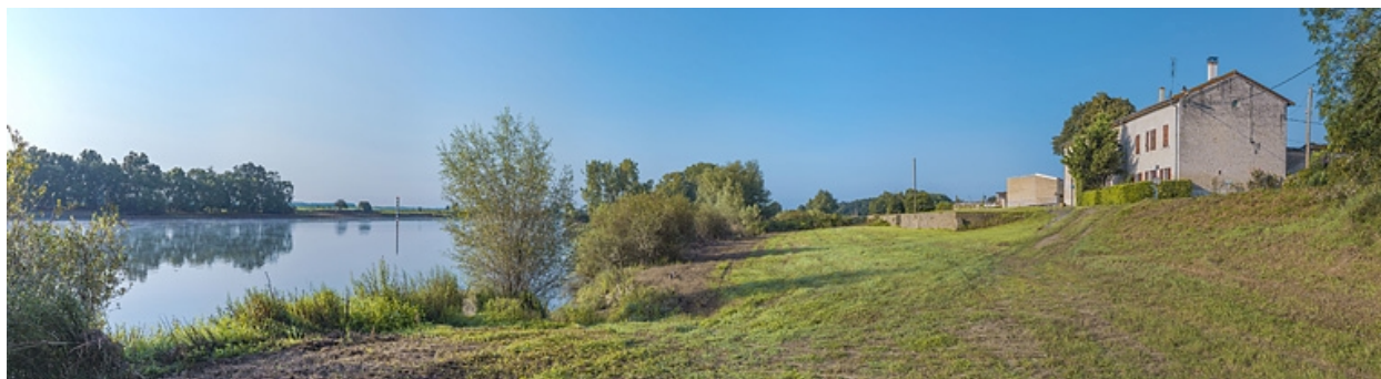
Le port de Farges : mur de soutènement.
