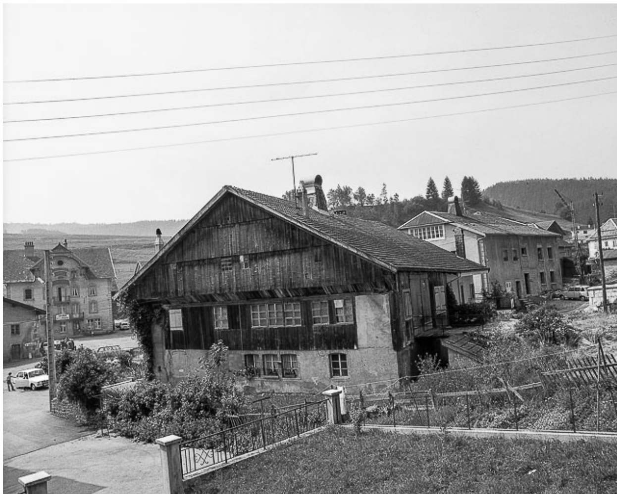
Façades postérieure et latérale droite, en 1976.
