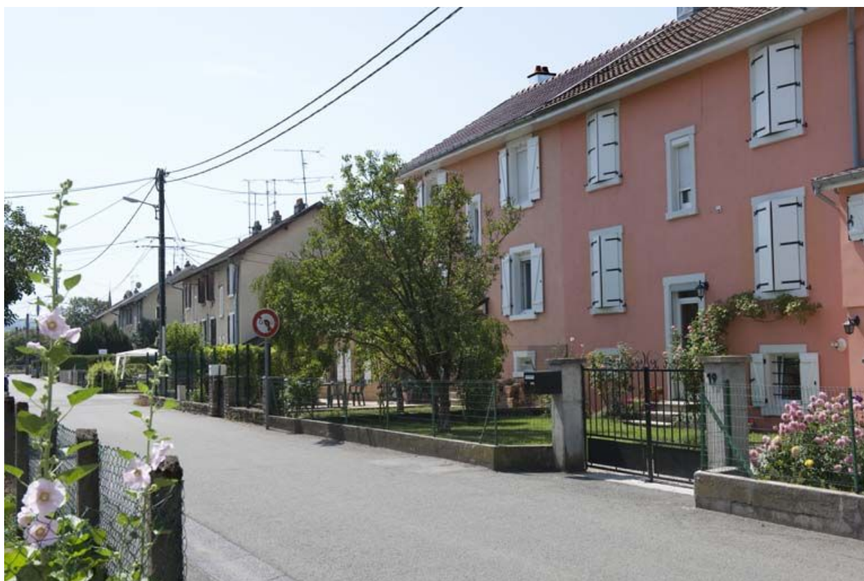
Vue d'ensemble rue du 11 Novembre.
