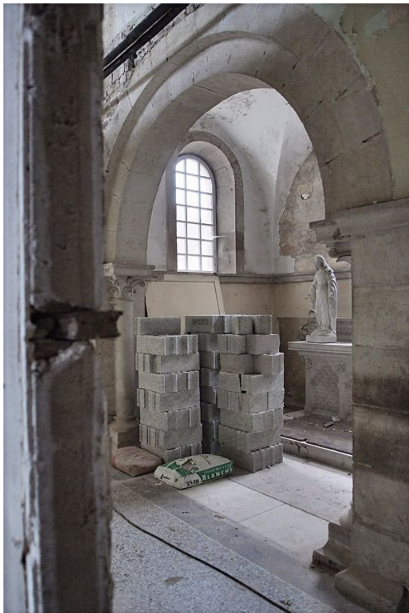
La chapelle pendant les travaux.
