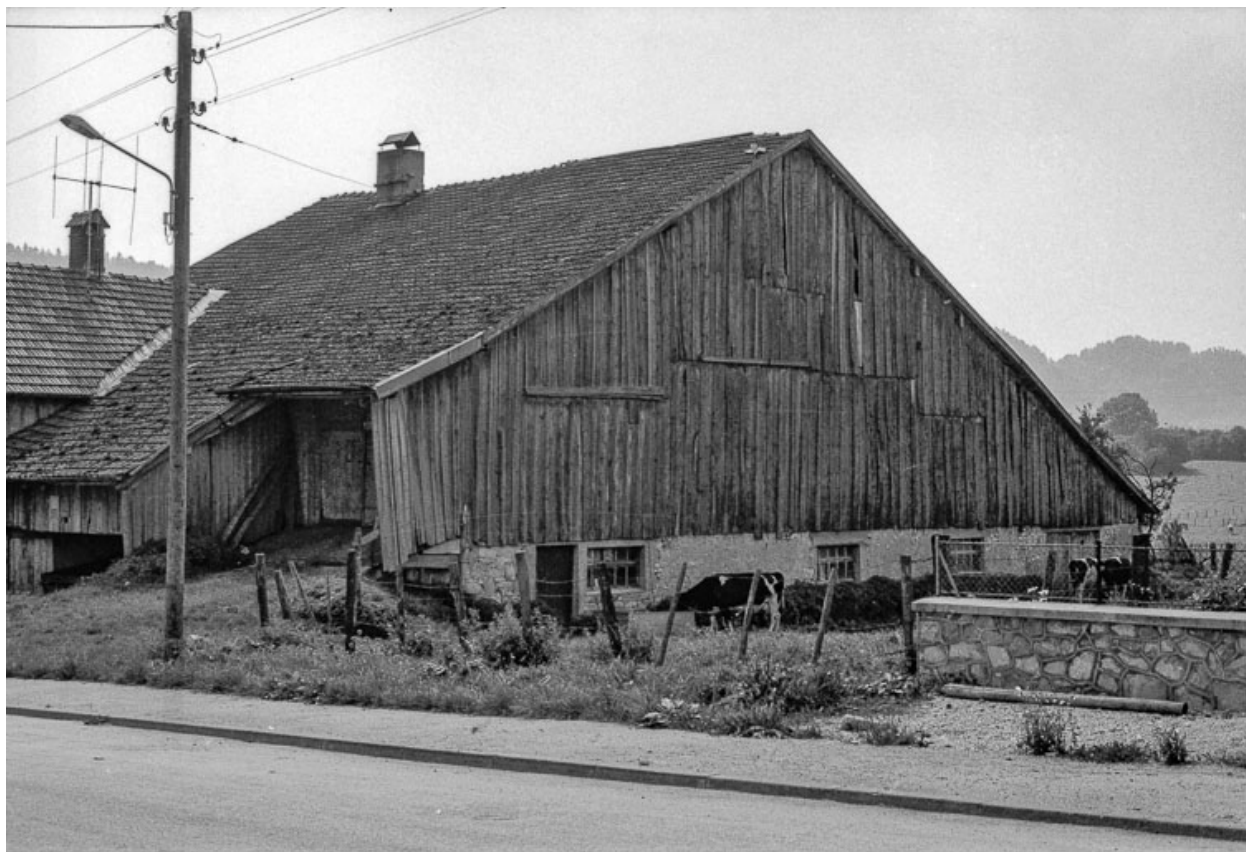
Ferme : façade latérale droite.
