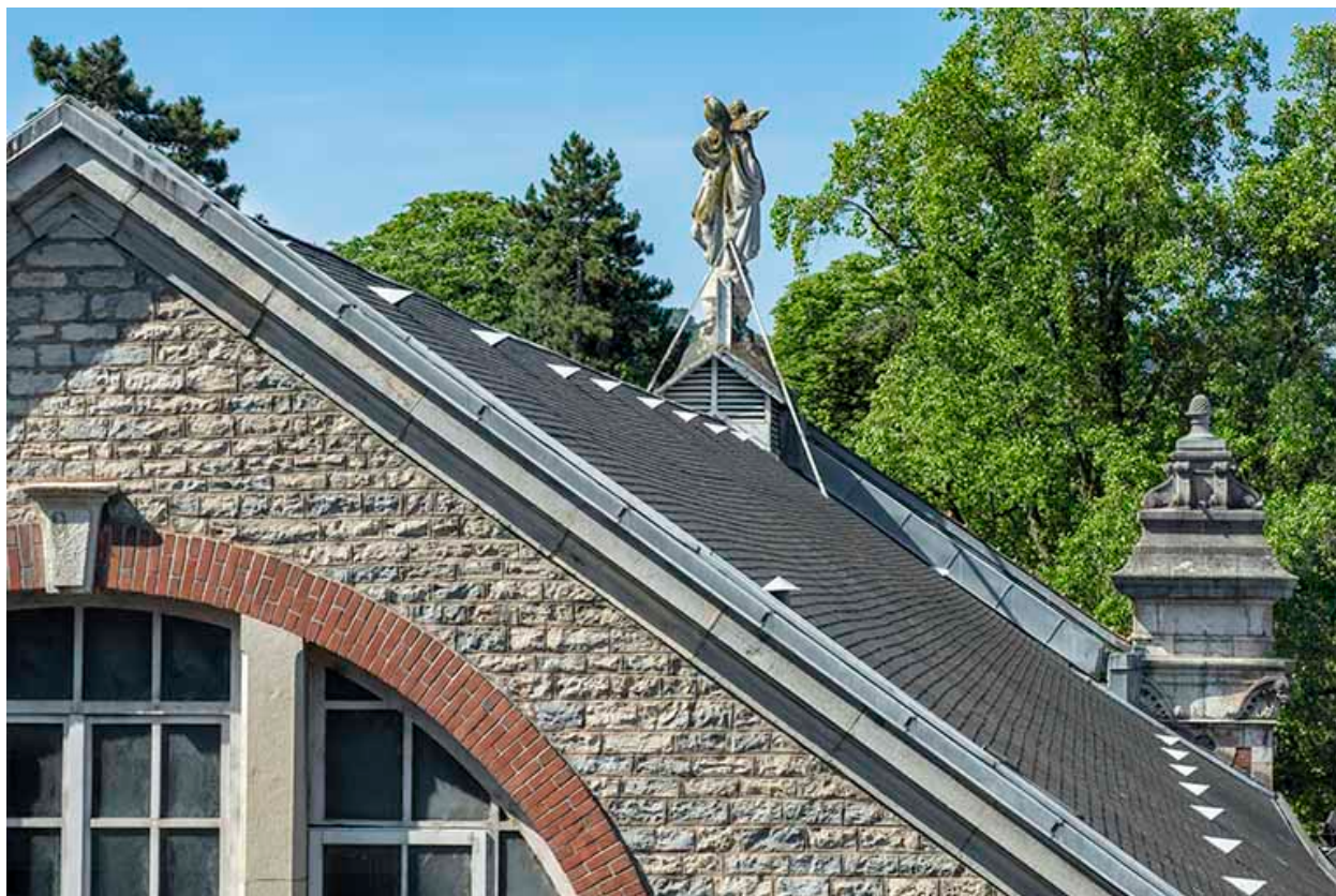
Toiture, vue depuis le nord.
