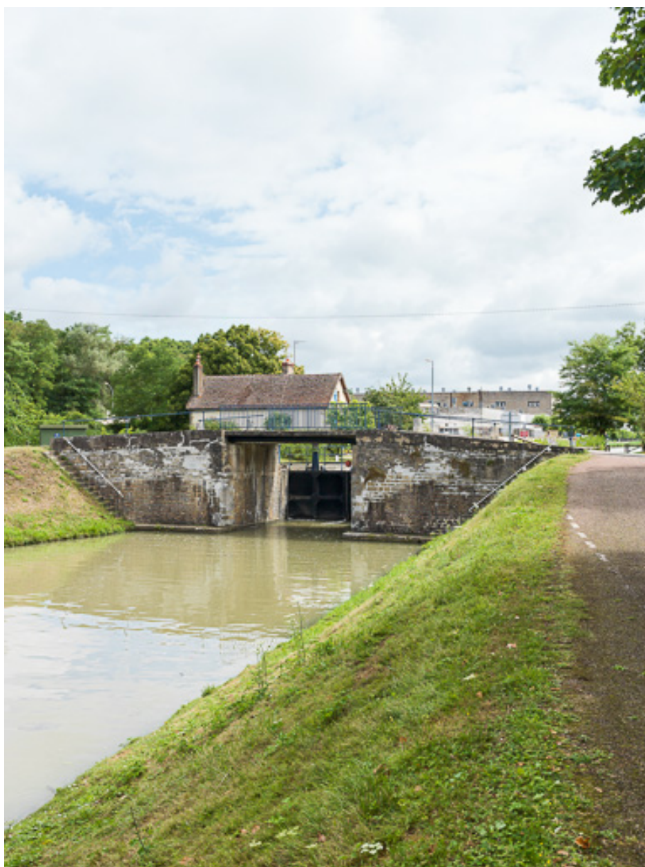
Vue d'ensemble du pont.
