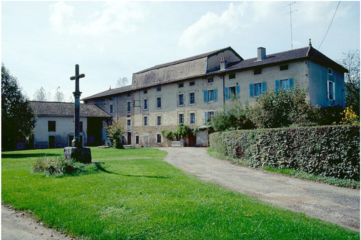
Vue d'ensemble depuis l'entrée de la cour.
