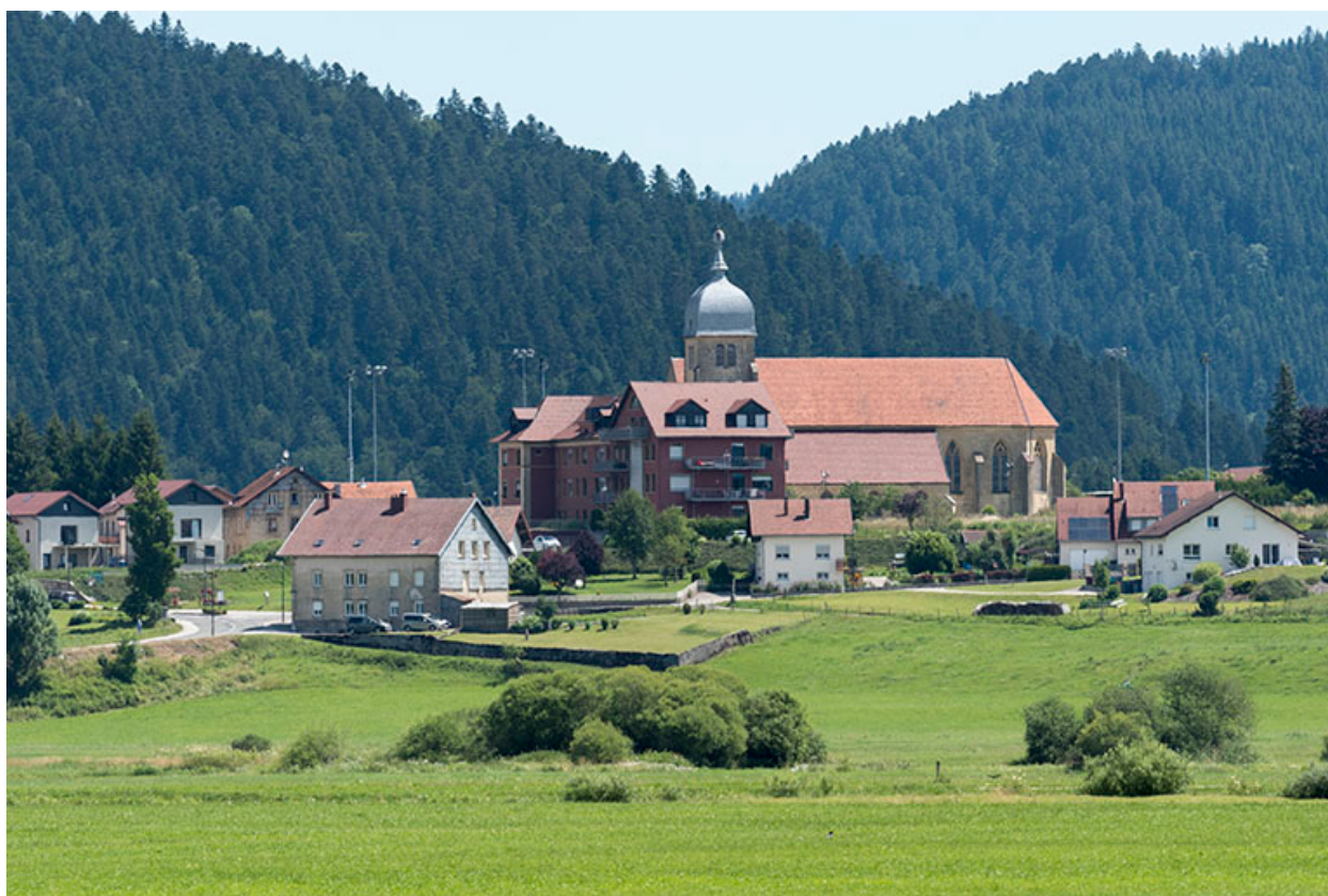
Vue d'ensemble, depuis l'ouest.
