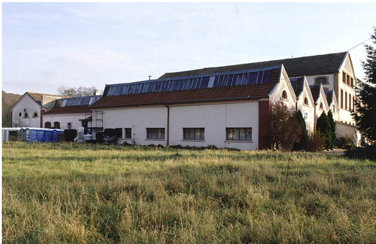
Vue de trois quarts depuis l'ouest.
