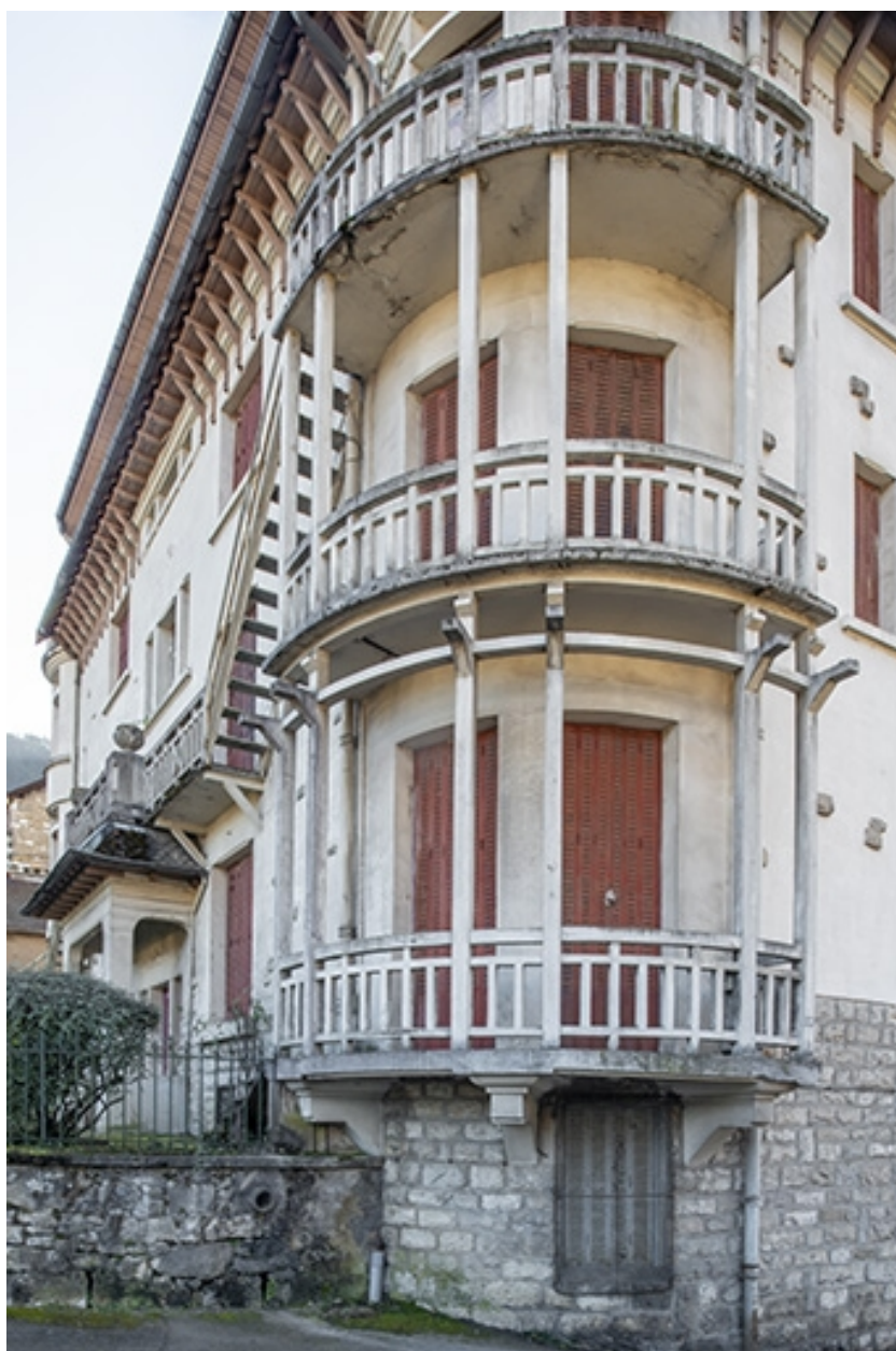
Balcons de l'angle nord-ouest.
