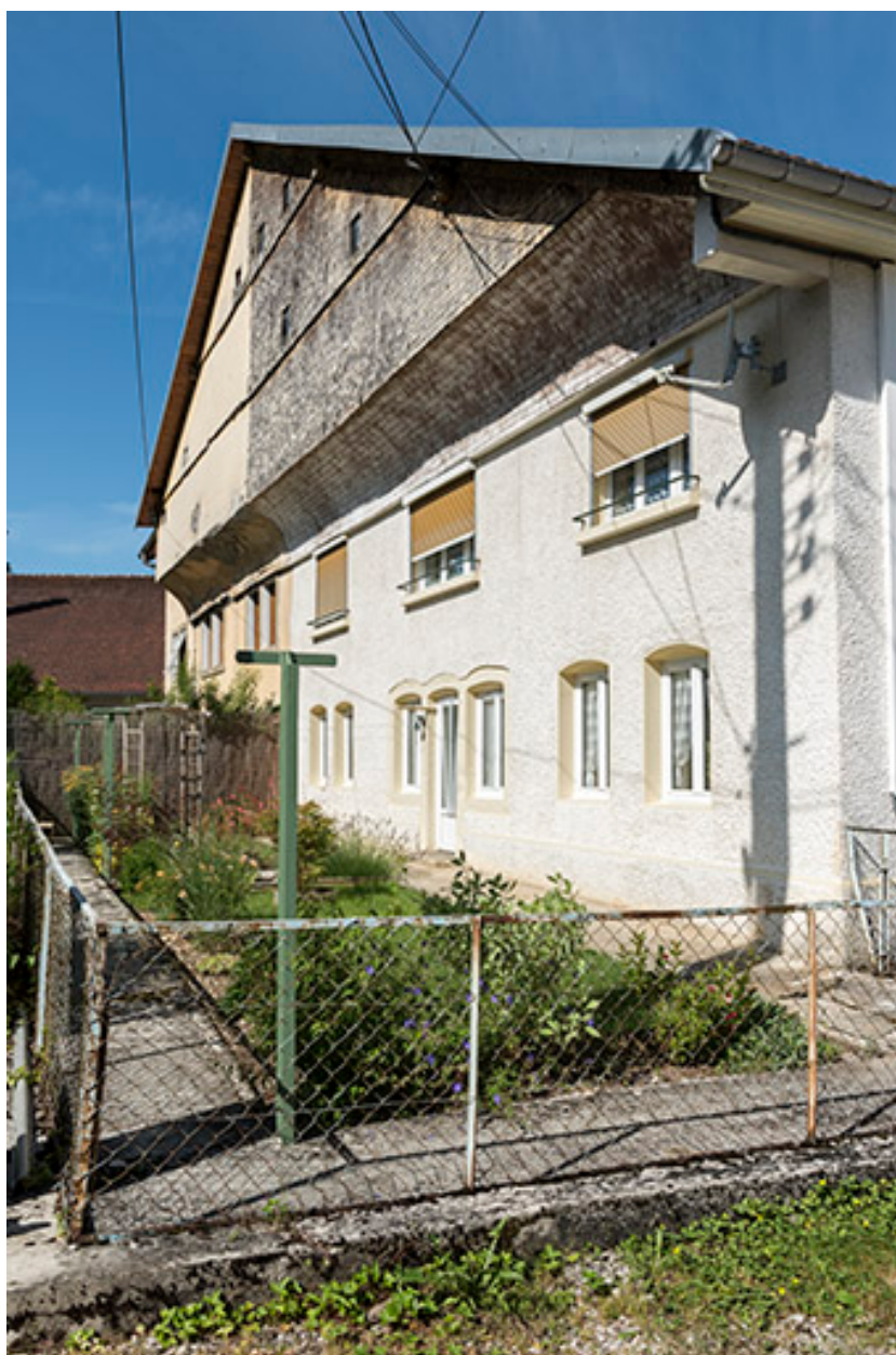
Façade postérieure, vue en enfilade.
