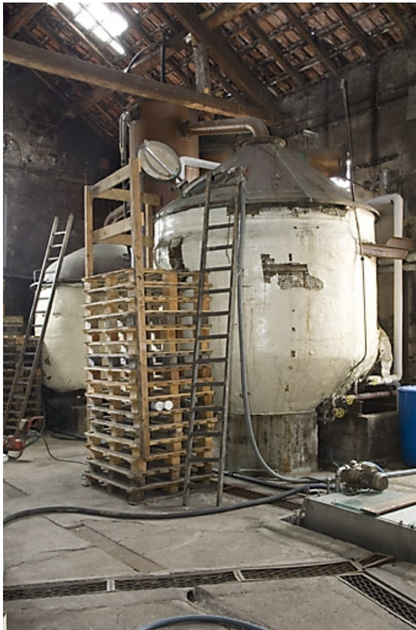
Ancien atelier de distillation. Alambics de 100 hl.
