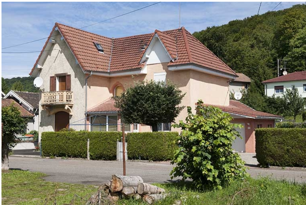
Maison de contremaîtres (n°12-14).
